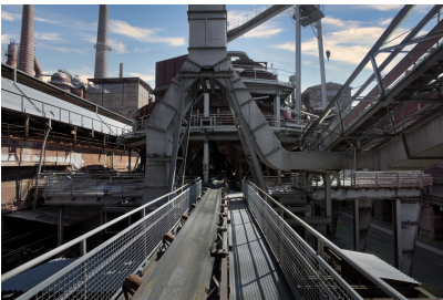
Entdeckerweg über den Sinterrundkühler und die Sinterentstaubung
