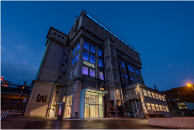
Le château d'eau du Patrimoine Mondial Völklinger Hütte
