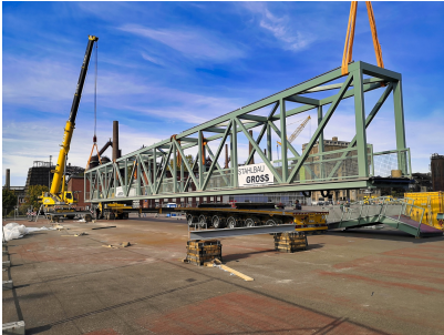
Neue Besucherbrücke zum Wasserhochbehälter
