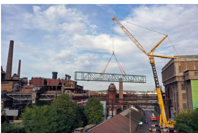
Einsetzen der Brücke zum Wasserhochbehälter Panoramablick
