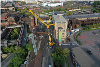
Einsetzen der neuen Besucherbrücke_Panoramablick
