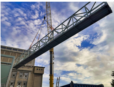
Die fliegende Brücke_Einsetzen der neuen Besucherbrücke zum Wasserhochbehälter
